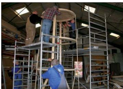
Der arbejdes ihærdigt på minifyrtårnet, som skal danne blikfang til Lemvig Marked og Dyrskue
